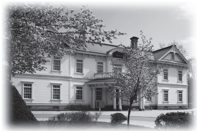
中島公園 豊平館(札幌市 中央区)
